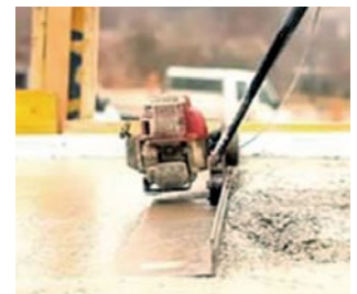
Bedněni lité betonové desky a její hutnění po betonáži
