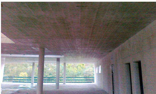
Hotová stropní deska
